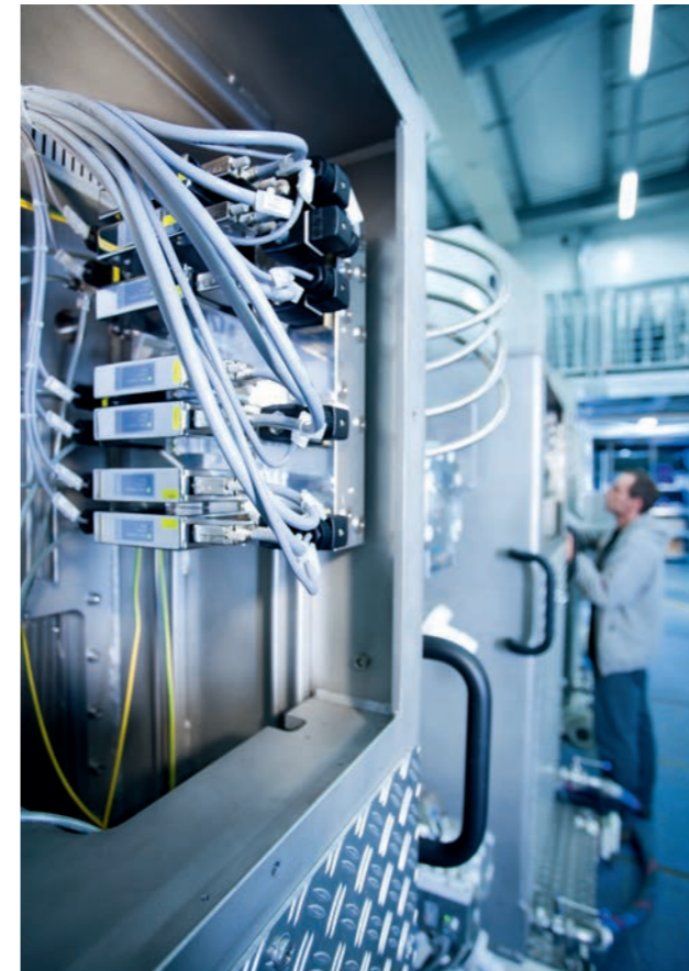
Installation de revêtement avec un contrôle des gaz entièrement automatisé.
